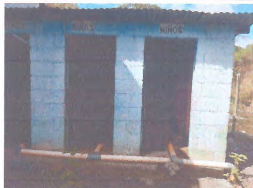
Foto 6: Reparación de red de drenaje y red de agua potable
