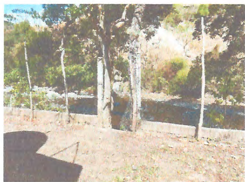
Foto 7: Mejora de cerco o muro perimetral
