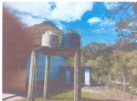
Foto 8: Mejora de cerco o muro perimetral y reparación de red de drenaje y red de agua potable
