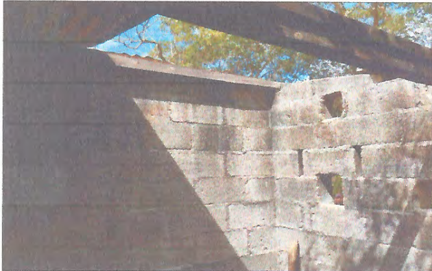
Foto 1: Mejoramiento de estructura de techo, Reparación o sustitución de area de roci na
