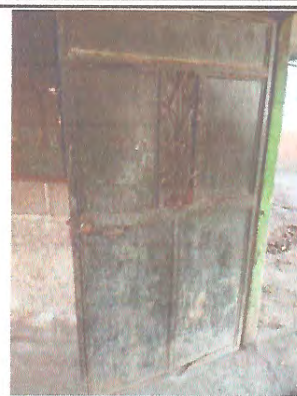
Foto 2: Mejoramiento de puertas
