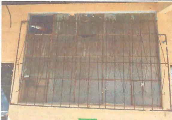
Foto 3: Mejoramiento de Ventanas
